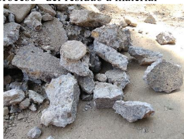
Figura 1. Escombros de un andén demolido
